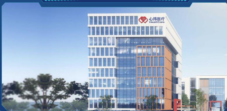
上海临港·心玮产业园（在建）
